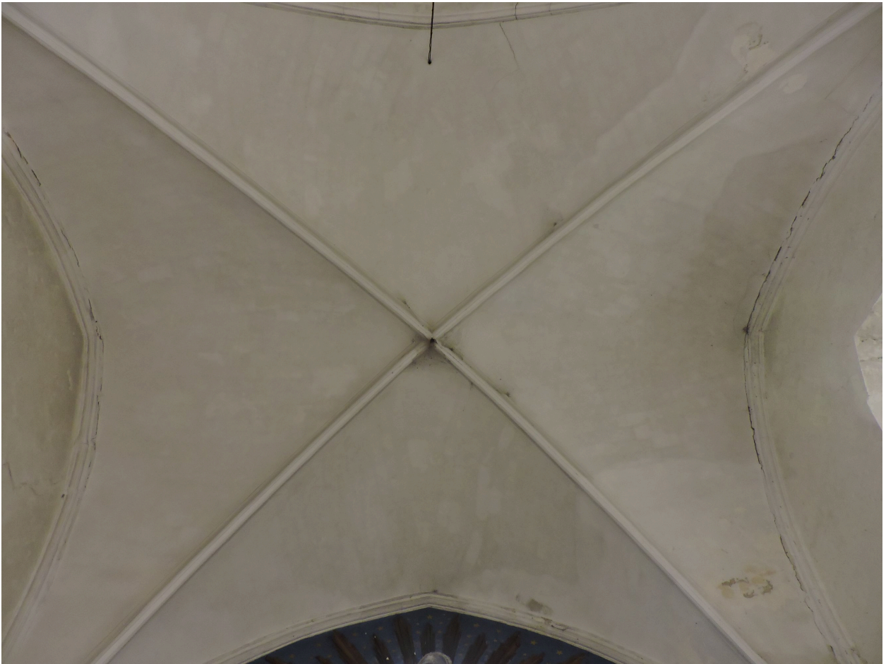
La voûte de la seconde travée du choeur.
