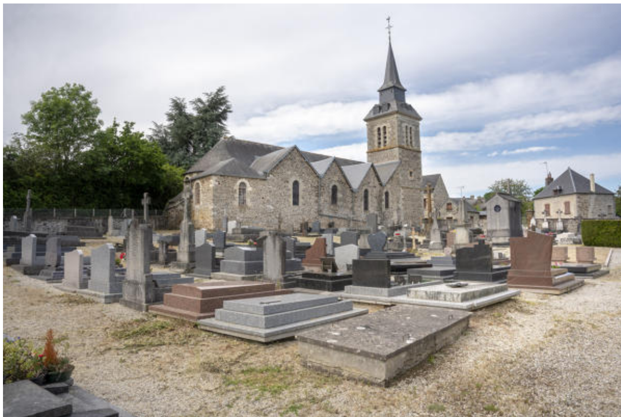
L'église depuis le nord-est, côté cimetière.
