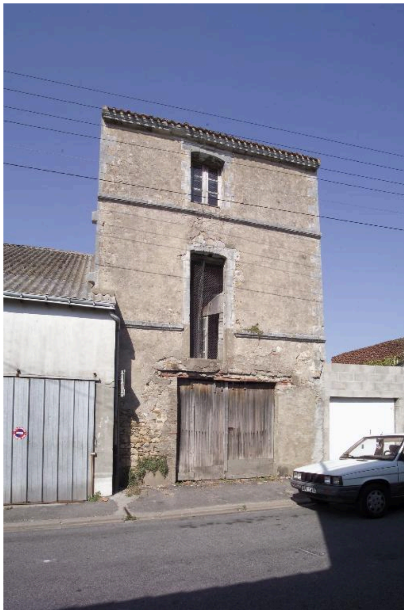
Façade antérieure, n° 46 rue du Faisan.
