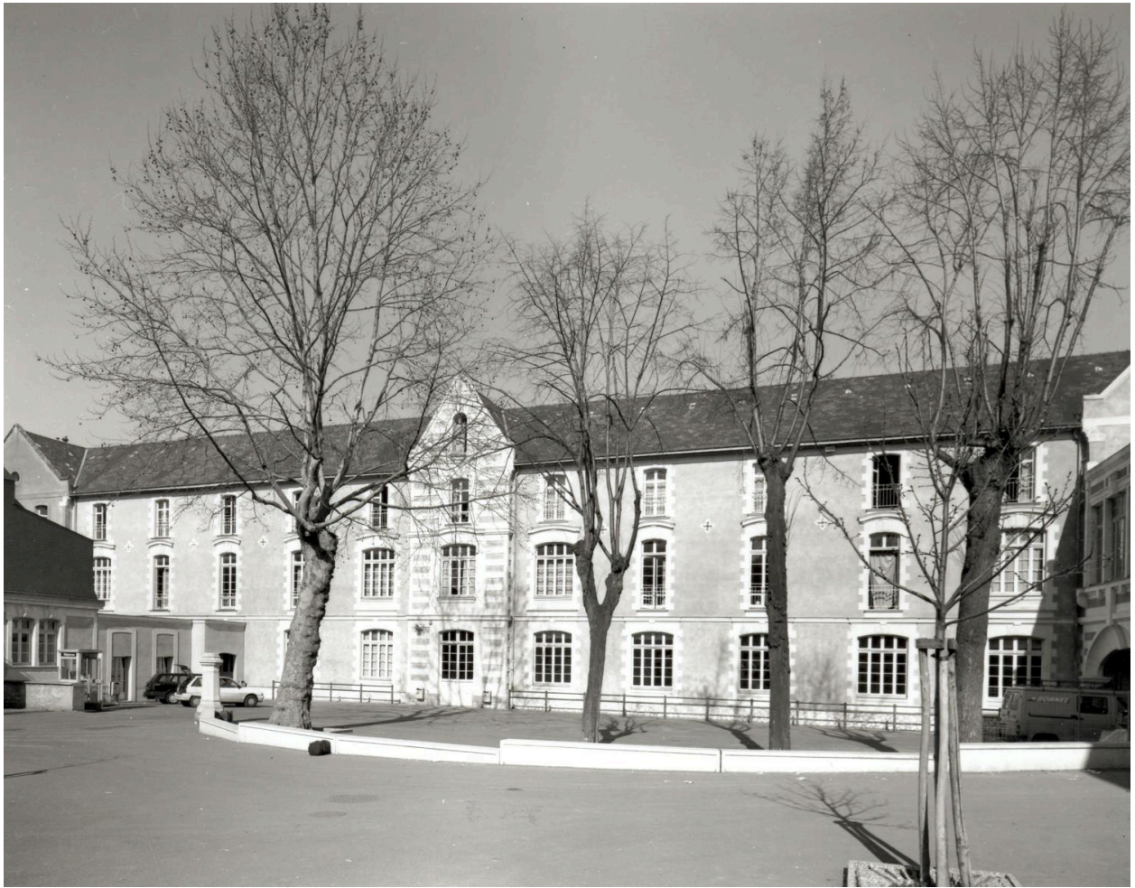
Externat Saint-Maurille, bâtiment scolaire nord : élévation antérieure.
