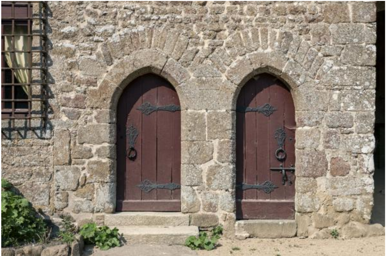
Portes de la tour orientale du châtelet.
