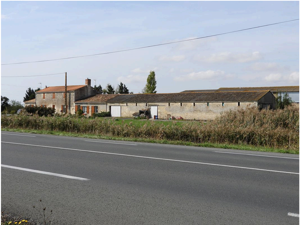
La cabane de Saint-André, ferme de plan allongé, avec grange à façade en pignon.
