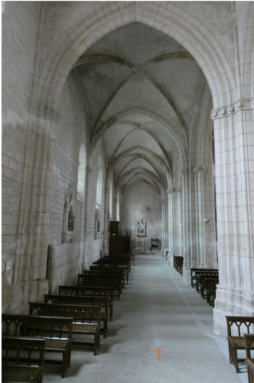
Le bas-côté sud vu depuis l'est.
