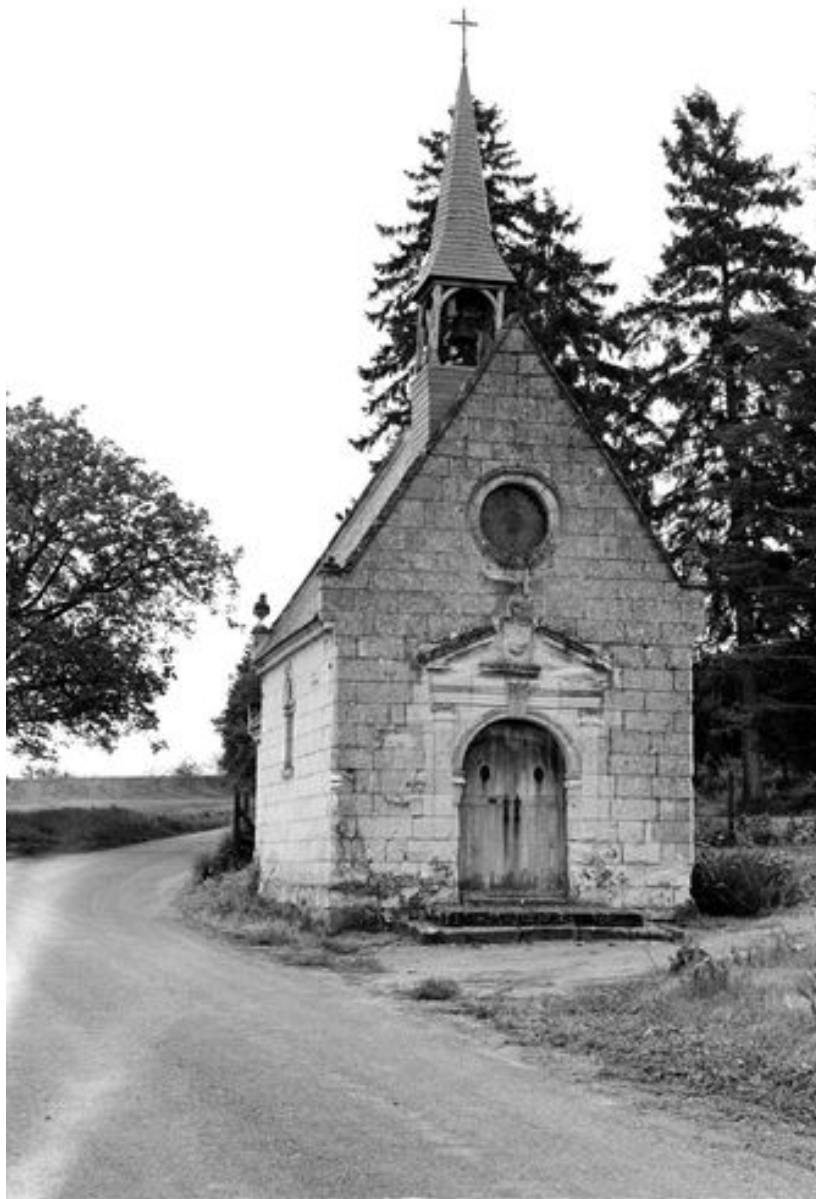
Vue générale avant restauration (vue prise en 1979).
