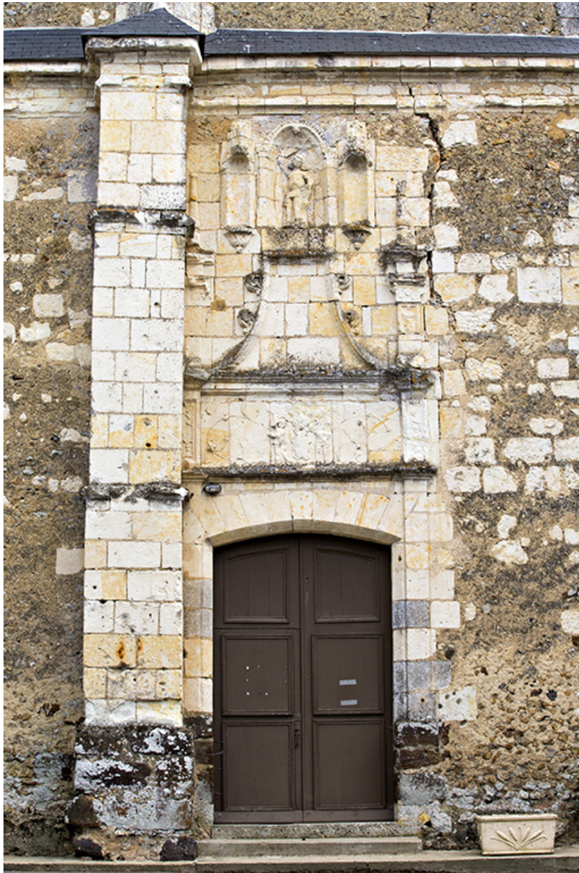
Portail occidental (1ère Renaissance).
