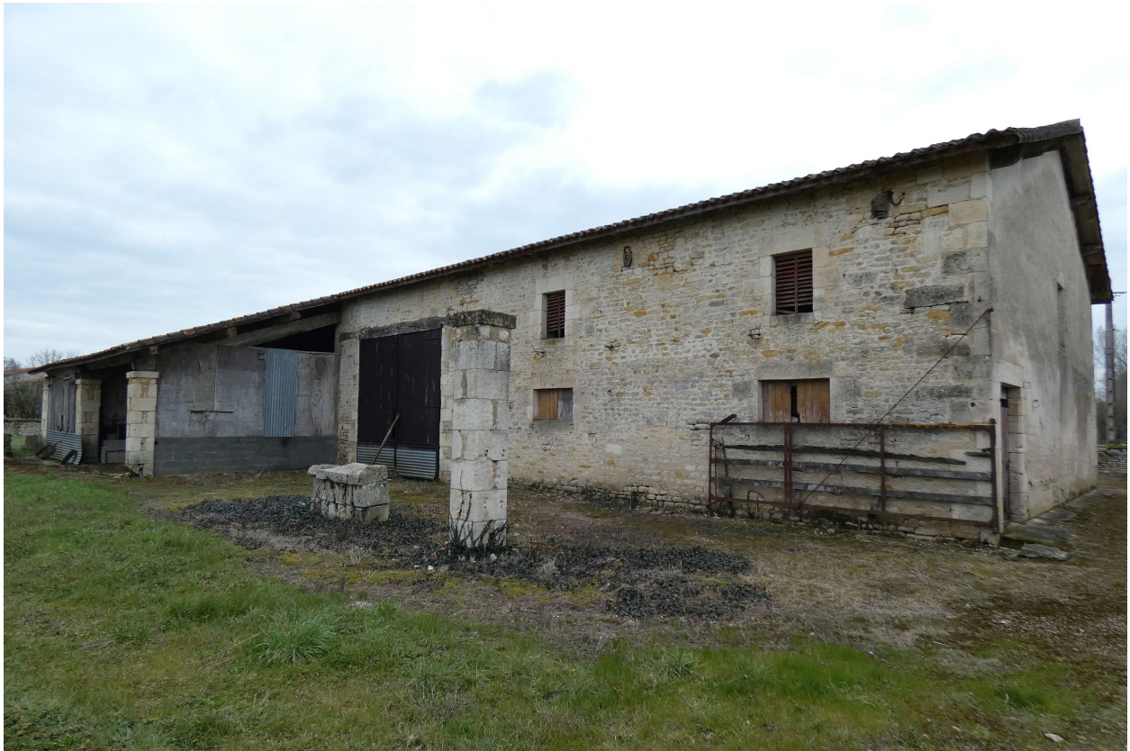
Vestiges de hangar à piliers en pierre à l'arrière de l'écurie.
