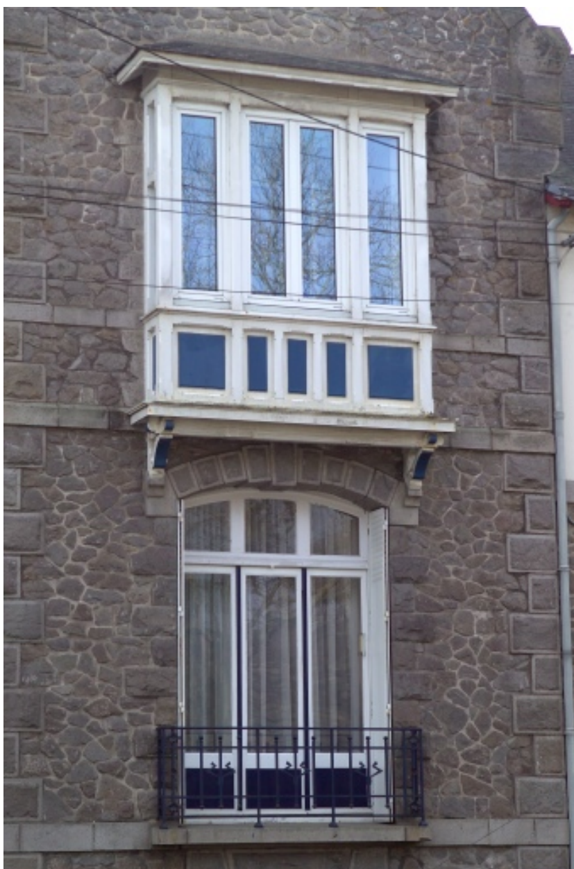
Détail des ouvertures sur la rue.
