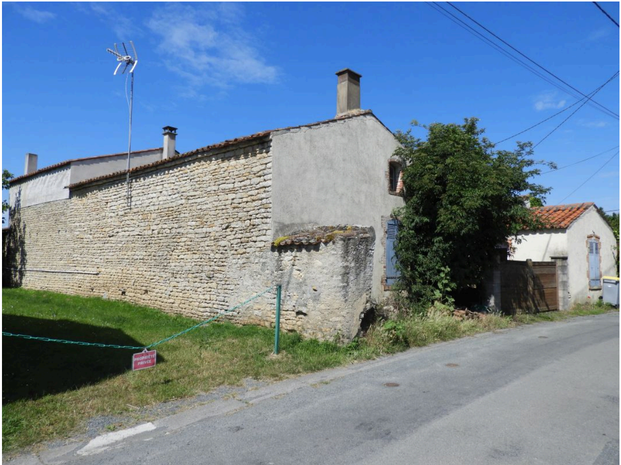
Le puits à l'angle de la maison, vu depuis l'est.
