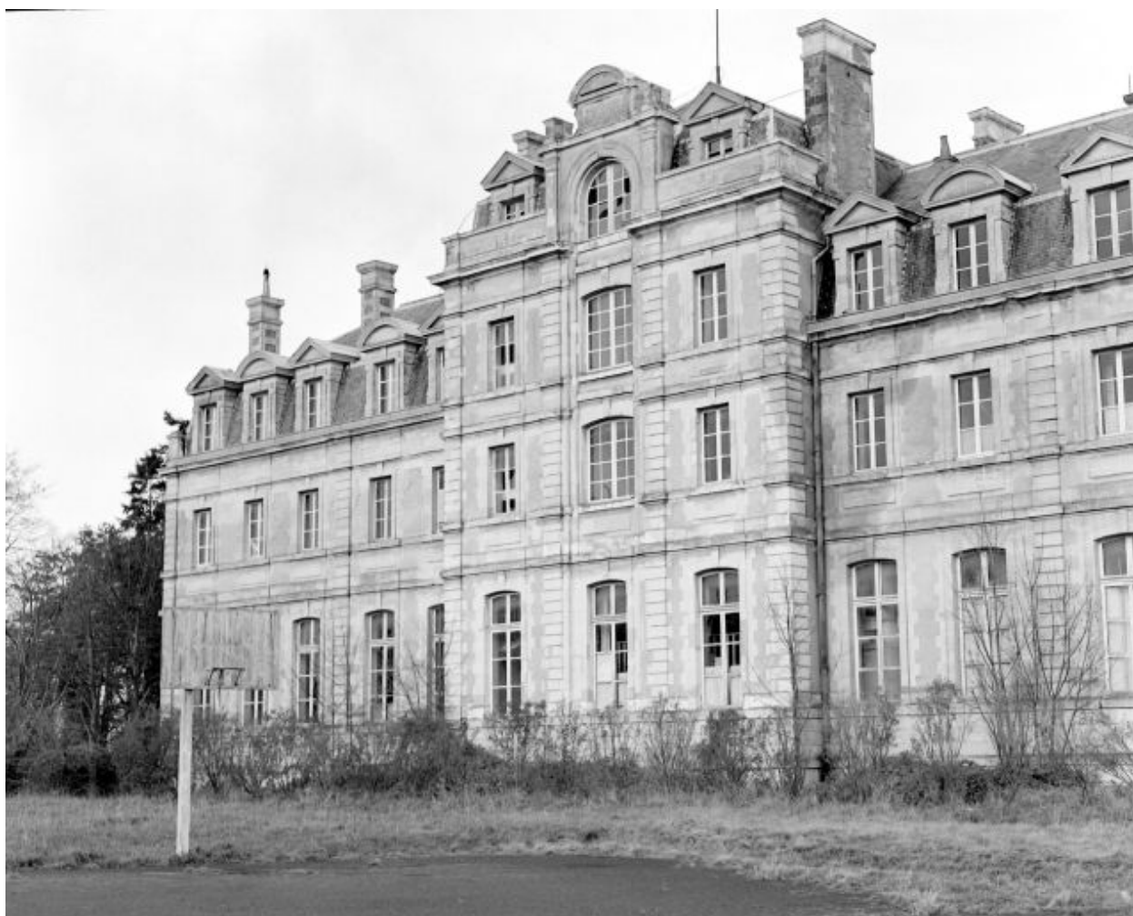
Façade sud : vue d'ensemble.
