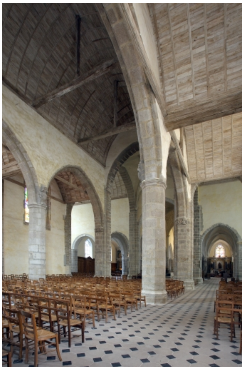
Nef et collatéraux restaurés : vue d'ensemble depuis le bas du collatéral droit.
