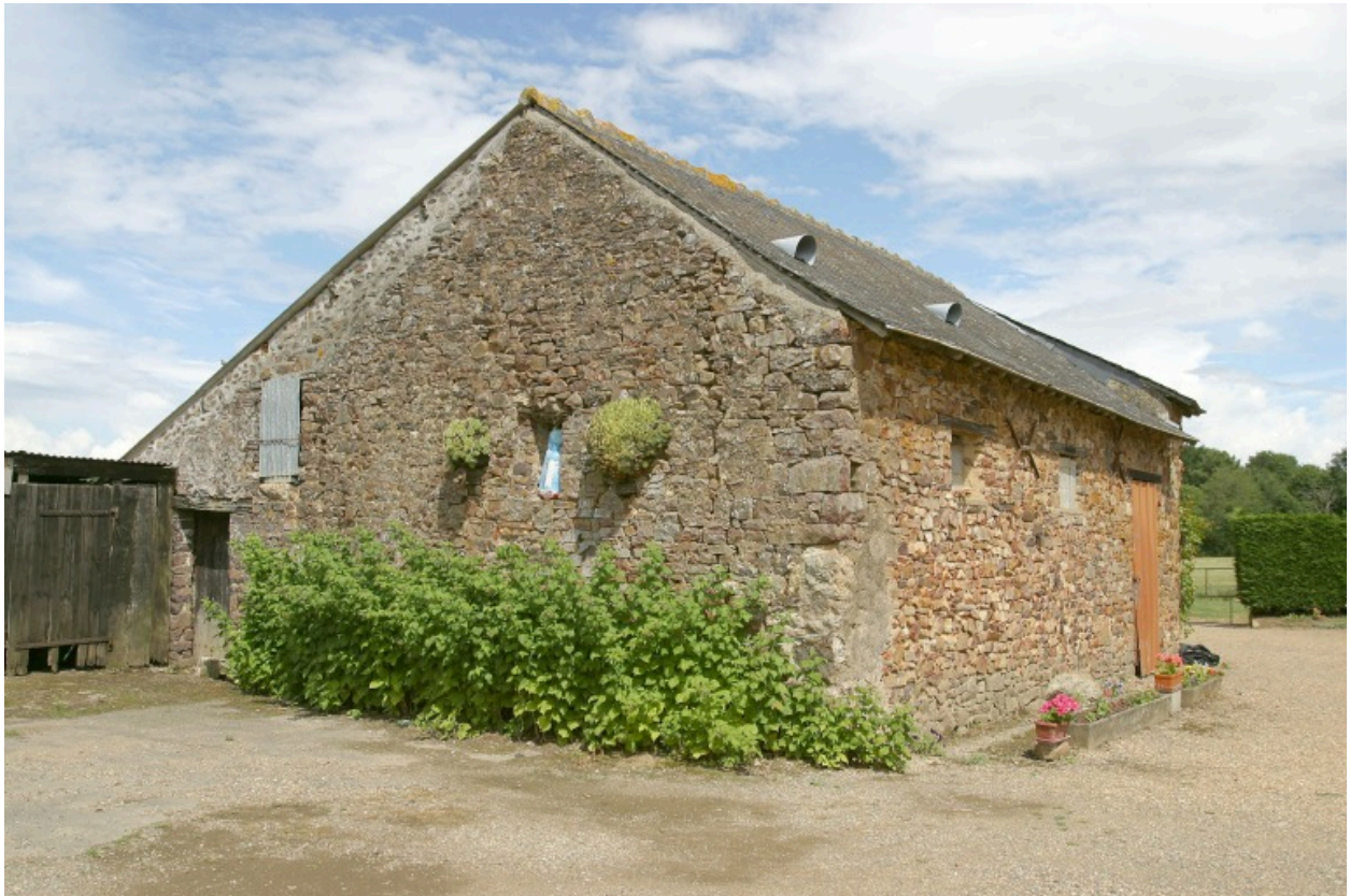
La partie ouest de l'étable-grange - ancien logis-, vue depuis le sud-ouest.
