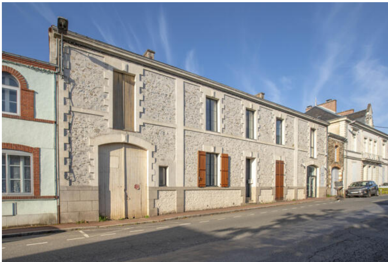
Vue générale de l'habitation et porte cochère donnant accès à la cour des communs.
