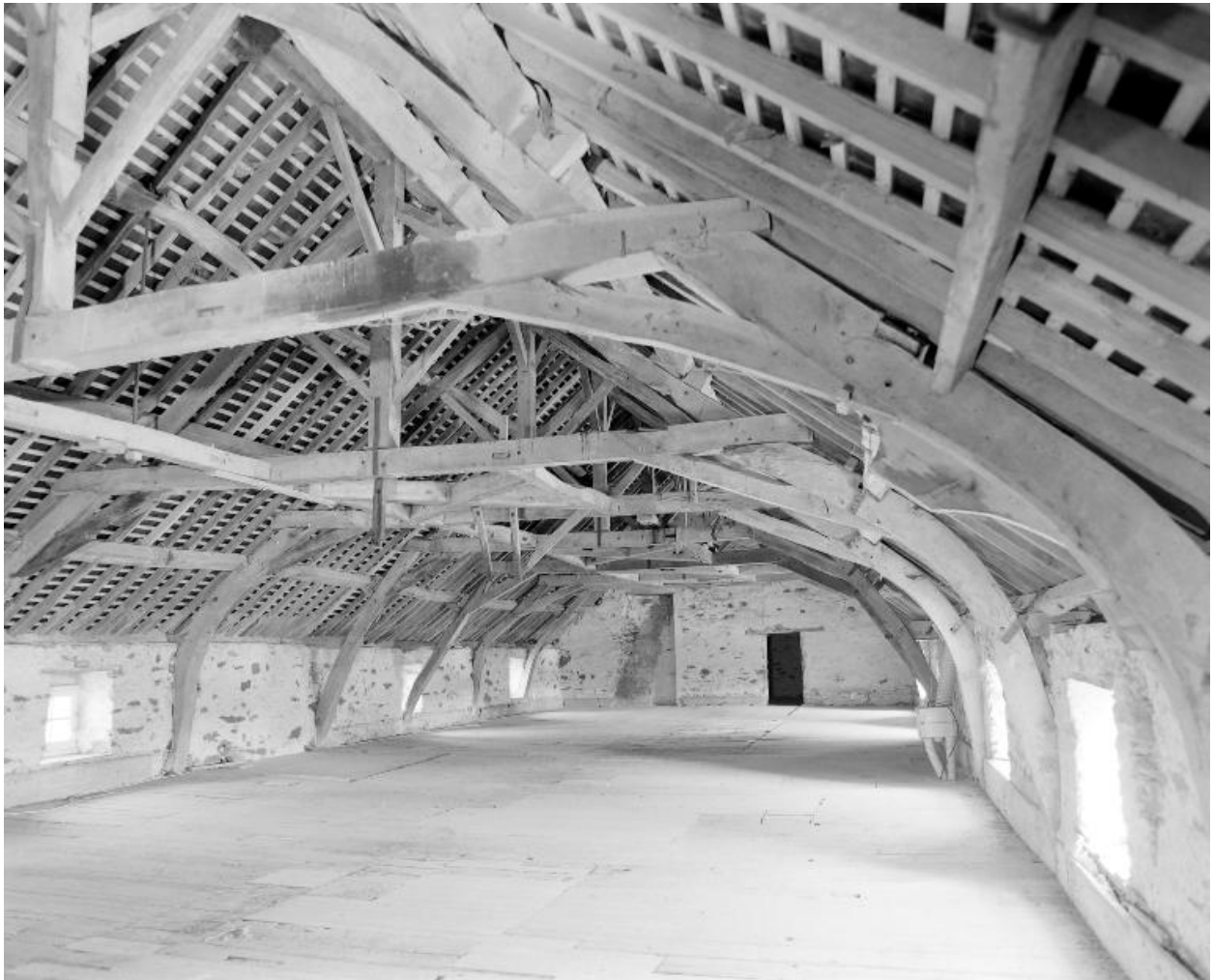
Le comble du moulin vu de l'ouest.
