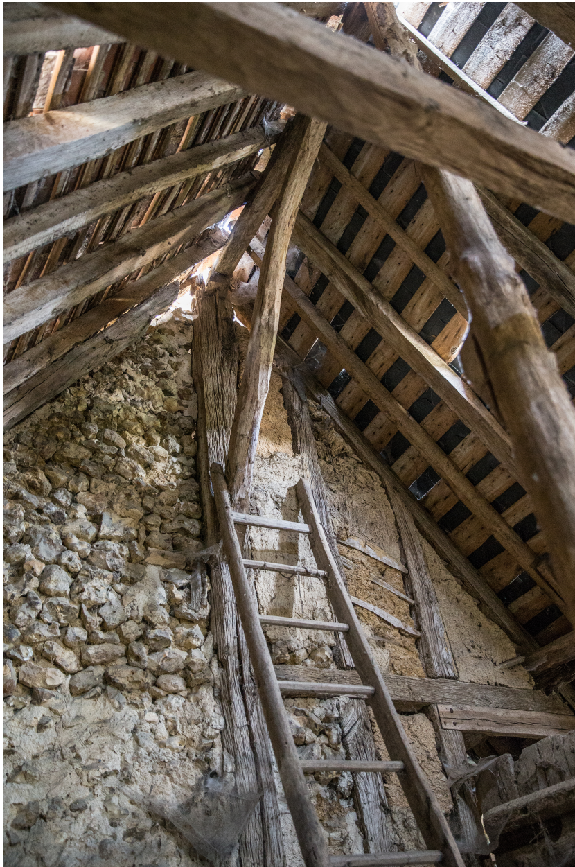
Le comble et la charpente du logement.
