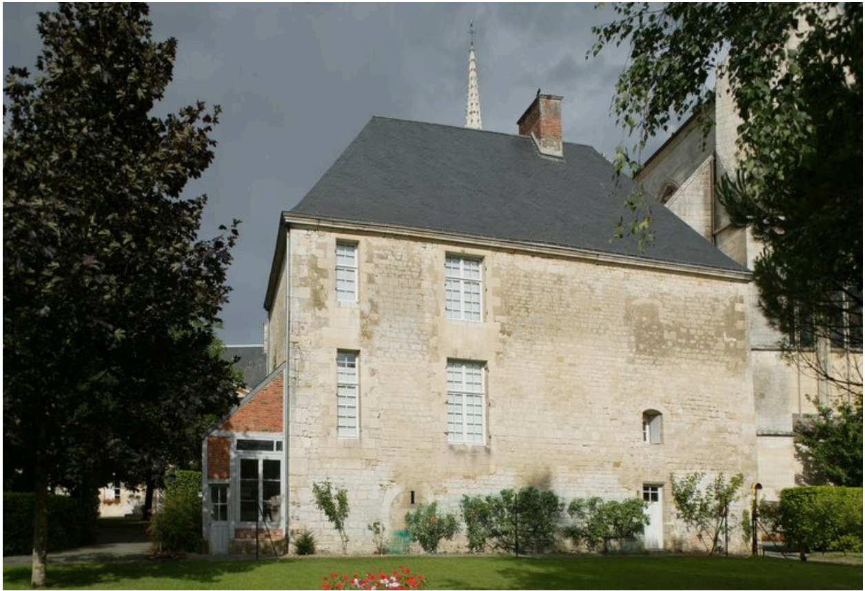
Bâtiment des archives : façade est.
