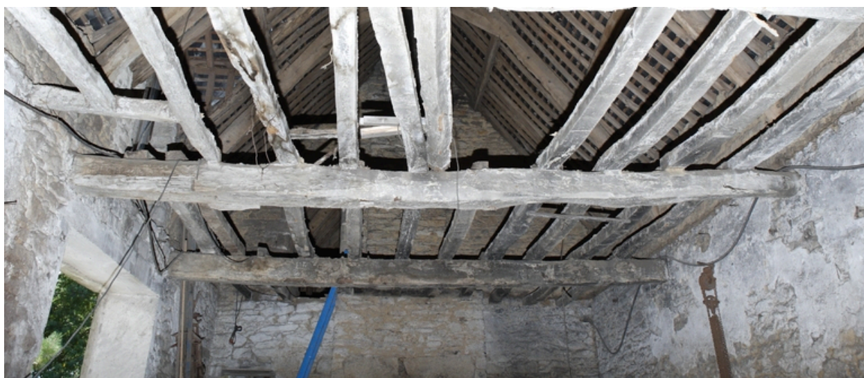
Bâtiment ouest. Détail du plancher.
