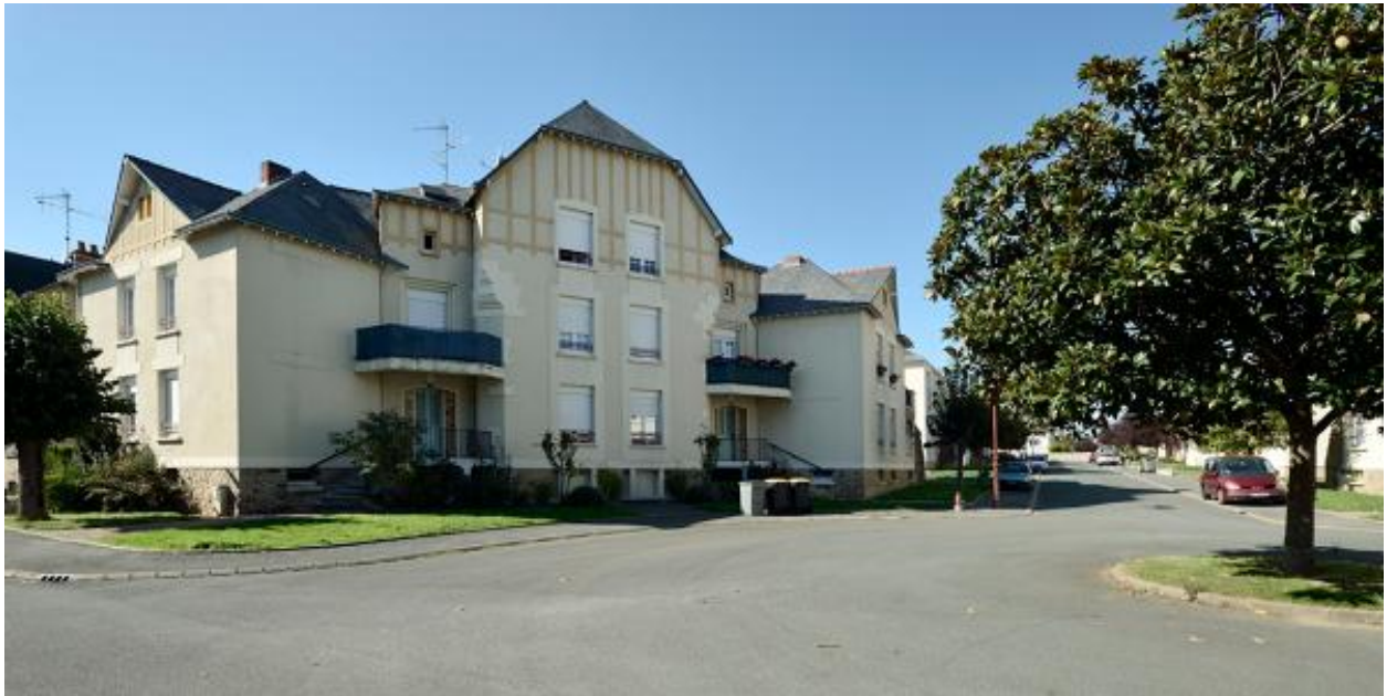
Immeuble à logements. 5, 7, 9 rue du Docteur-Baruck. Vue depuis le sud-est.
