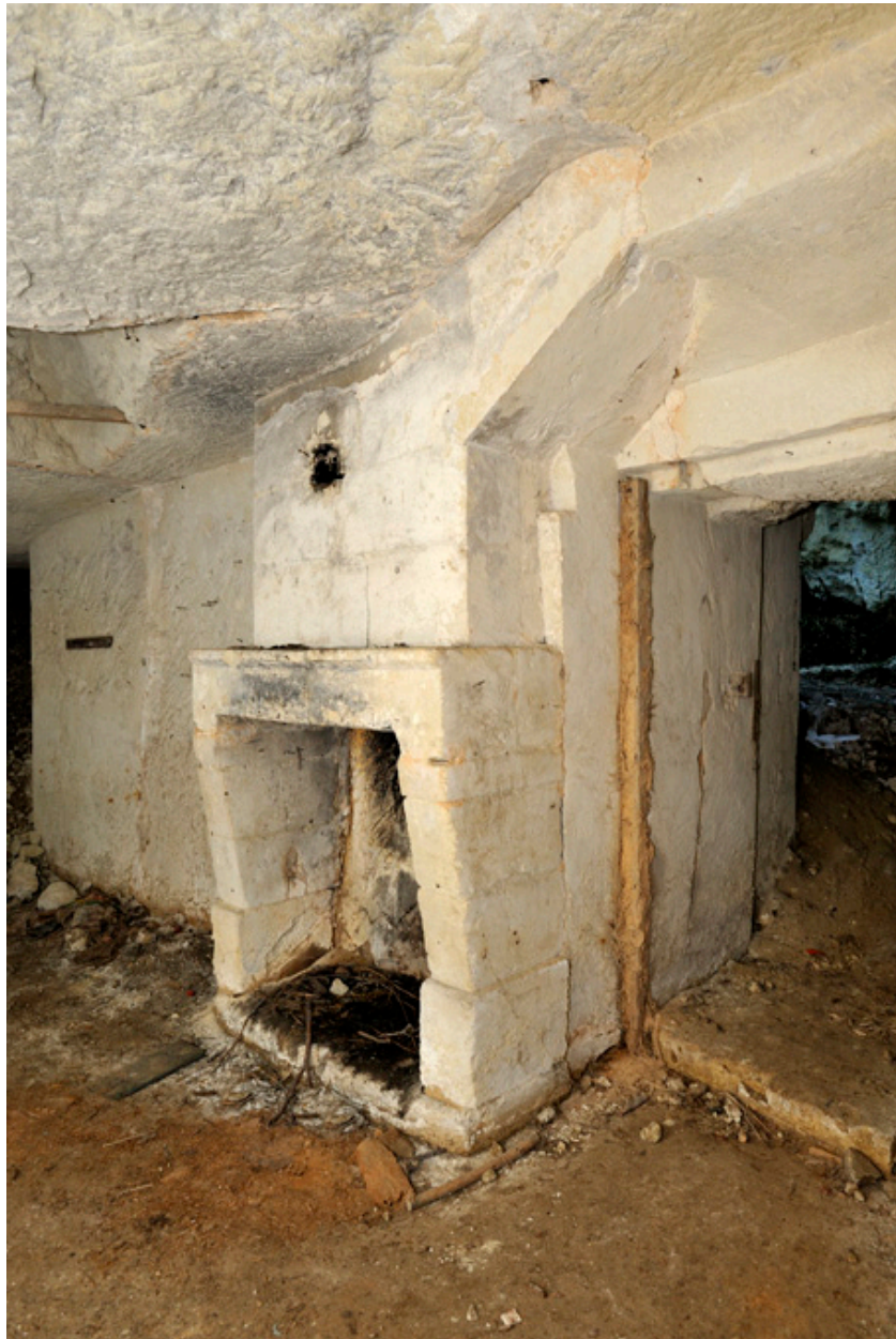
Site principal (11-16, ruelle des Perreyeurs). Fontis est. Abri troglodytique ouest, première salle : cheminée.
