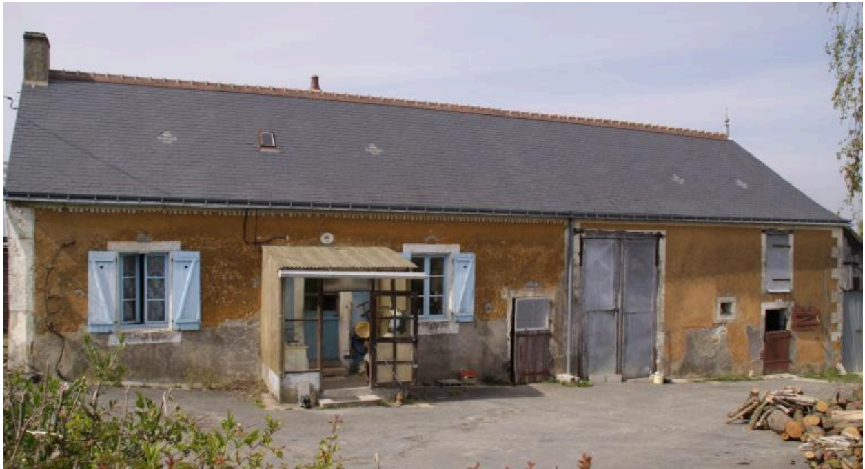
Ferme bloc à terre : façade antérieure sur cour.
