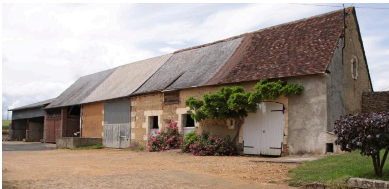
Grange et étables, face à la maison.
