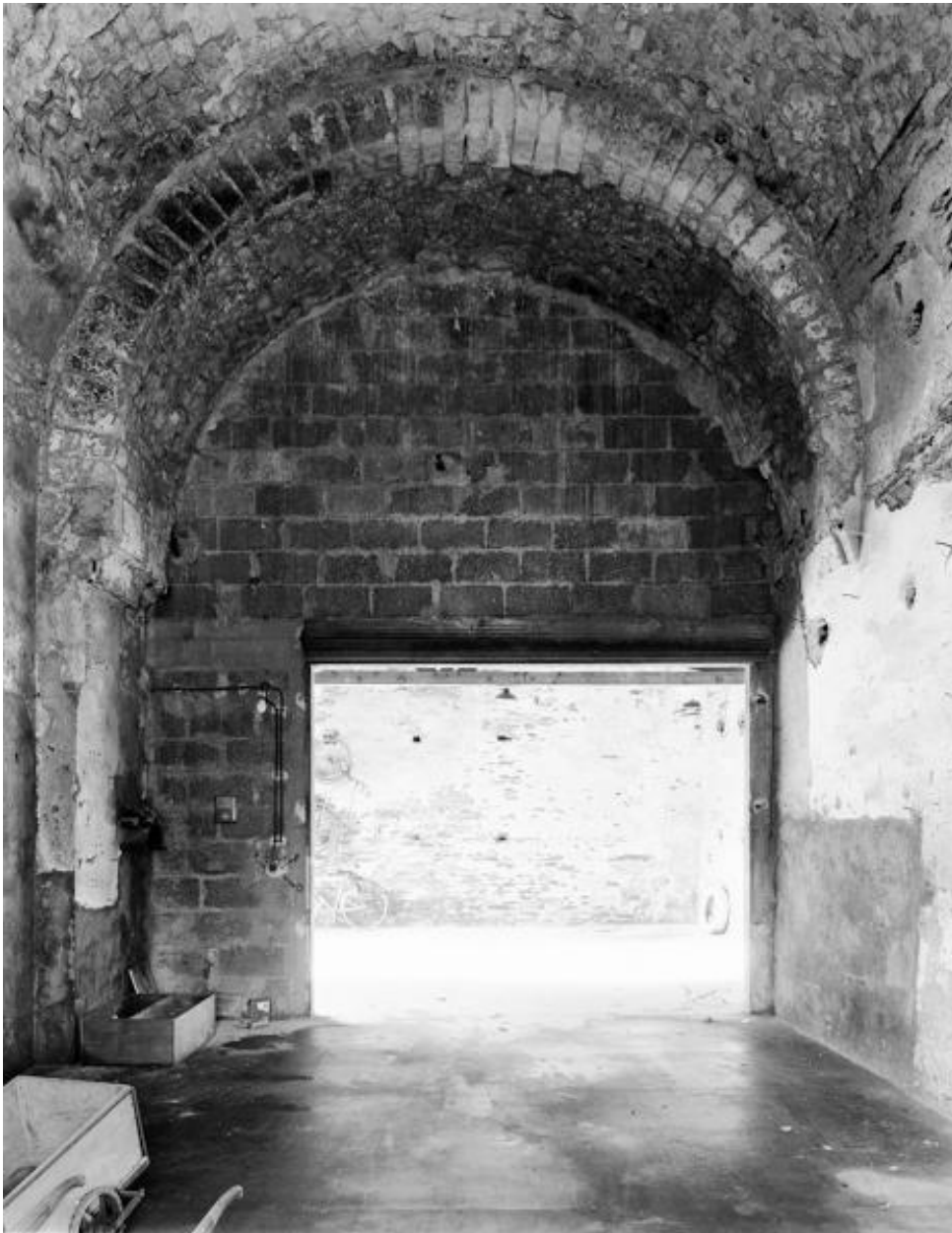
Absidiole nord : élévation intérieure, vers l'ouest.
