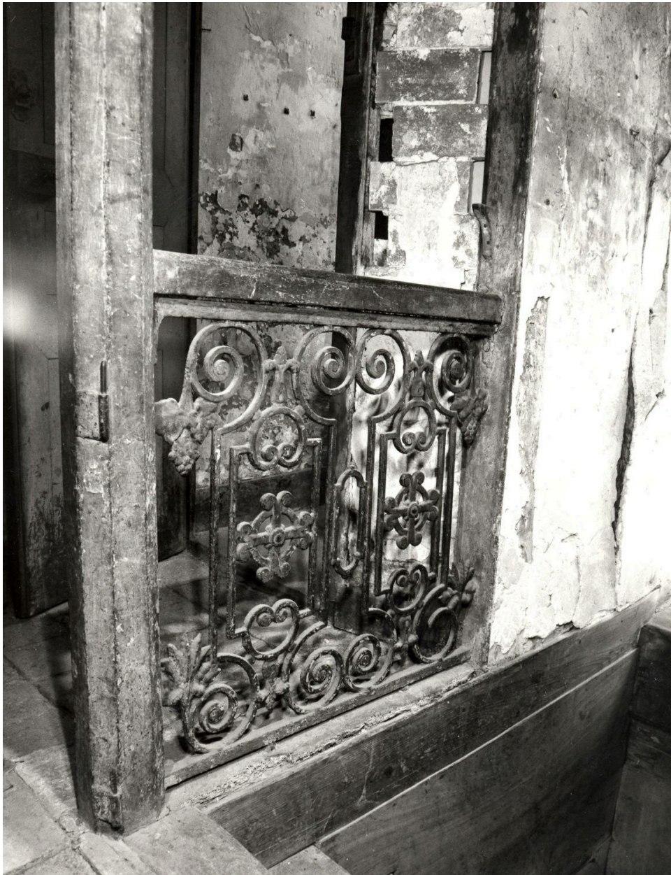
Cage d'escalier, palier du 1er étage.
