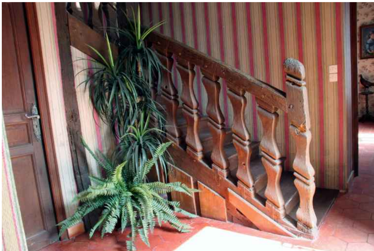
Escalier à noyau creux à trois volées.
