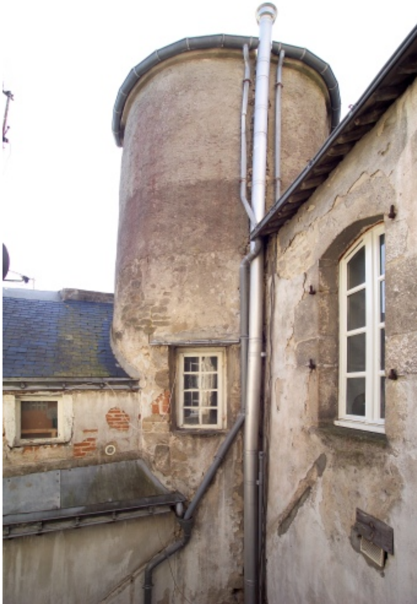
Vue de la façade postérieure et de la tour d'escalier.
