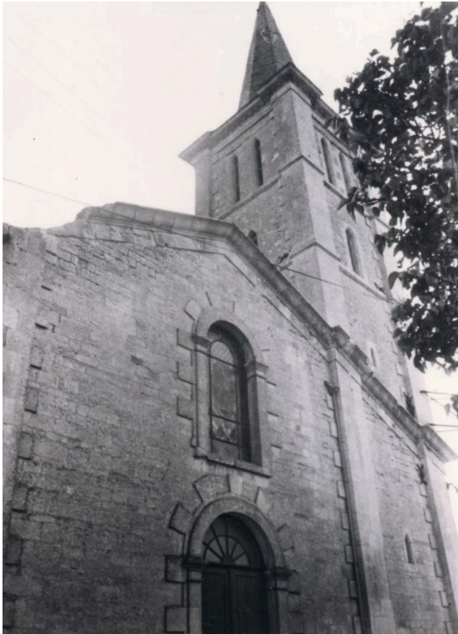
La façade nord-ouest de l'ancienne église vue depuis le nord vers 1970.
