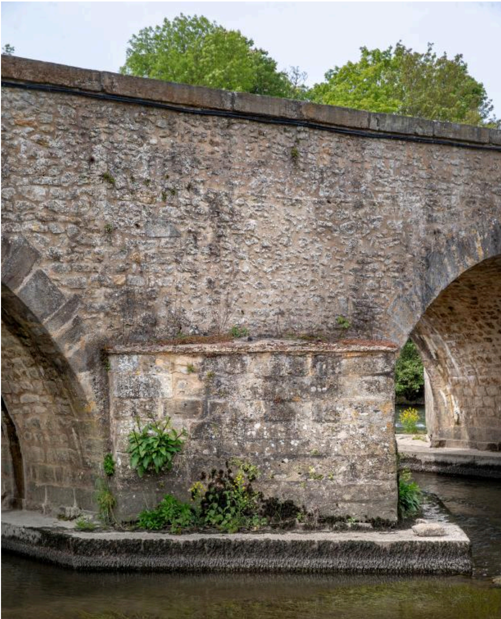
Le pont, face nord, détail d'un éperon.
