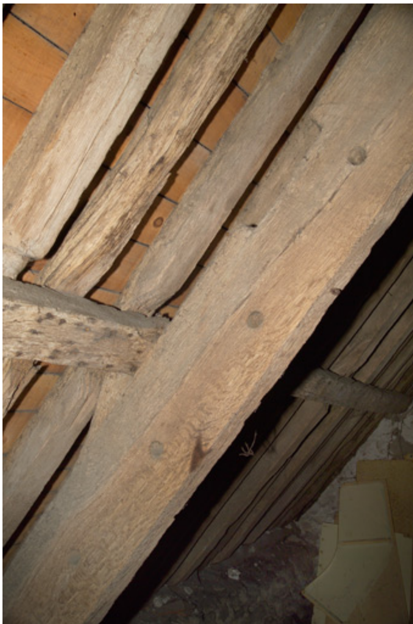
Corps principal, combles, détail de la charpente.
