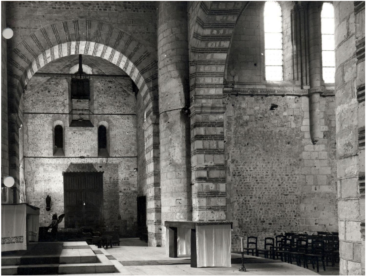
Croisée du transept , angle nord-est.
