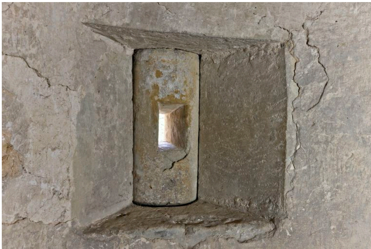
Vue intérieure de la meurtrière à rotule de la tour.
