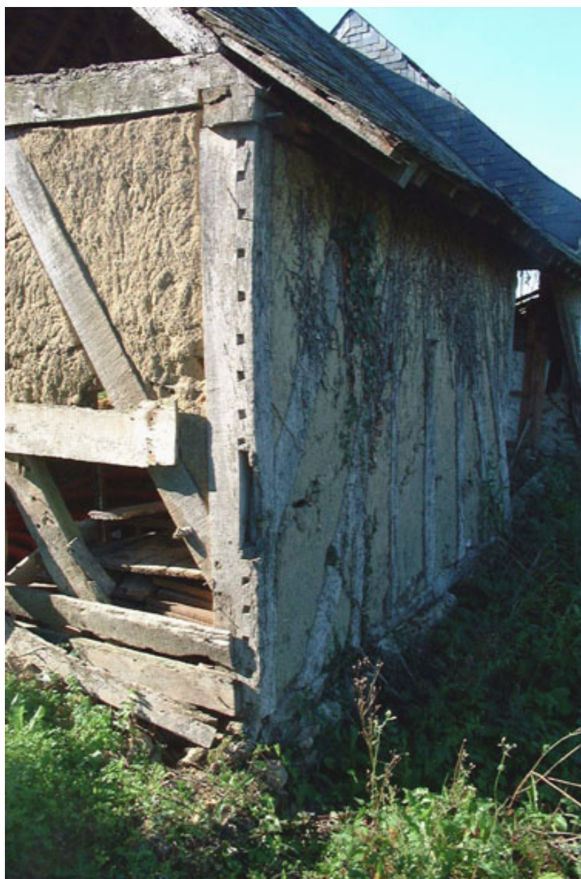
Pan de bois : détail du traitement de l'angle. Solin en pierre pour le gouttereau.
