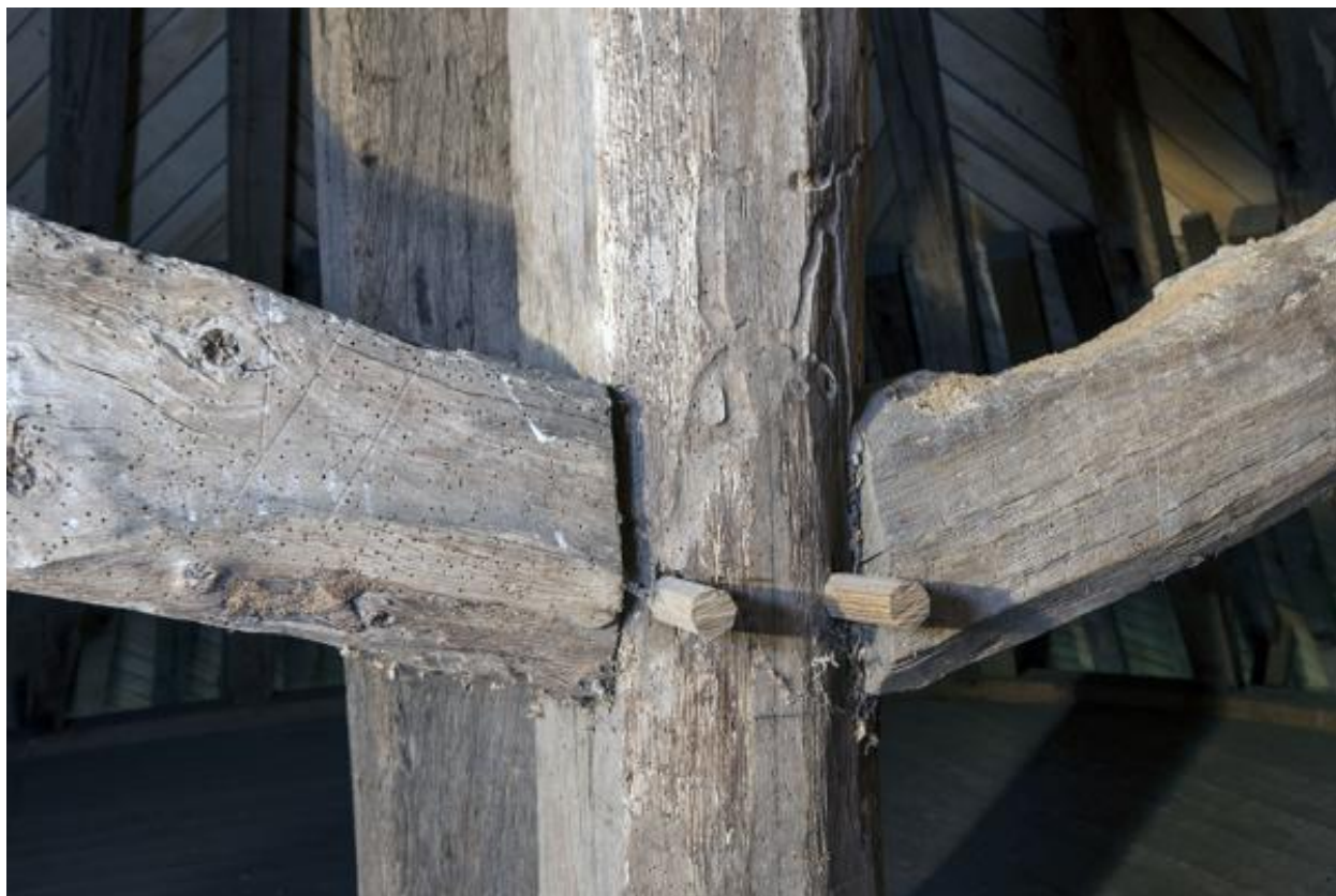
Charpente de la tour occidentale du châtelet, détail.
