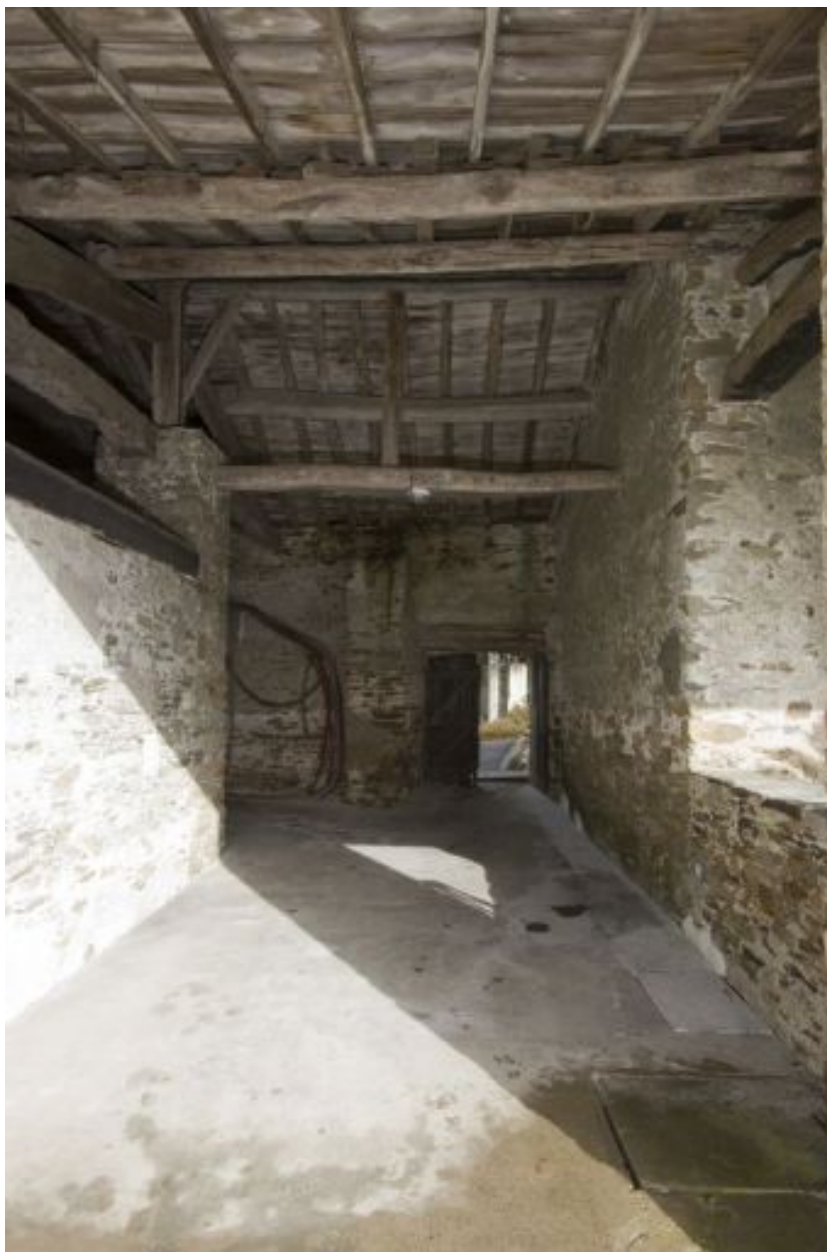
Les dépendances nord : le passage charretier.
