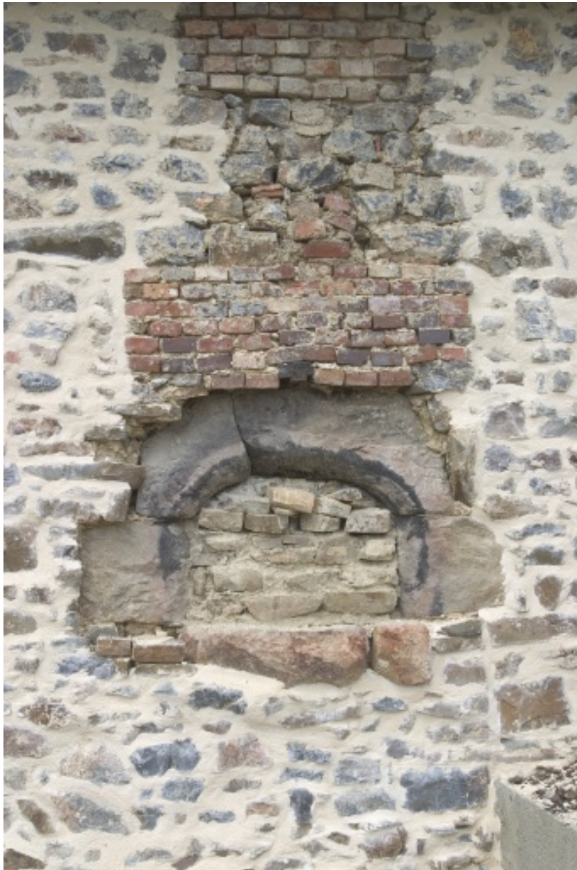
Les vestiges du four à pain sur la façade postérieure du logis.
