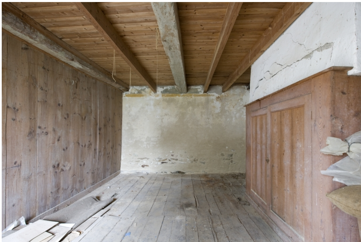
N° 10 rue Basse. Étage. Vue d'ensemble depuis le nord.
