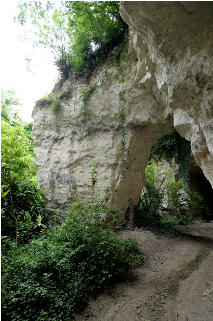
Site principal (11-16, ruelle des Perreyeurs). Fontis ouest. Arche (2).
