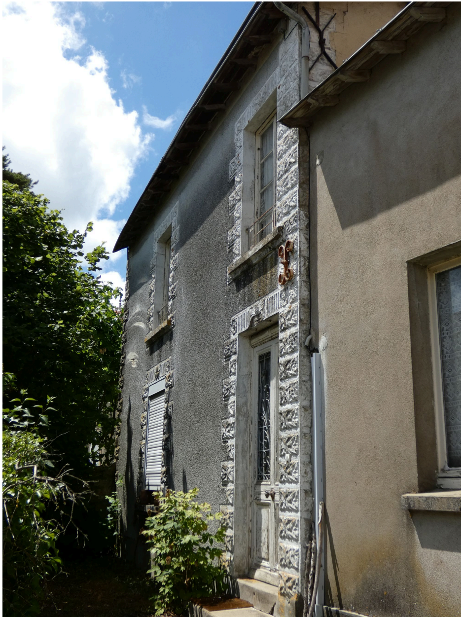
La façade de la maison.
