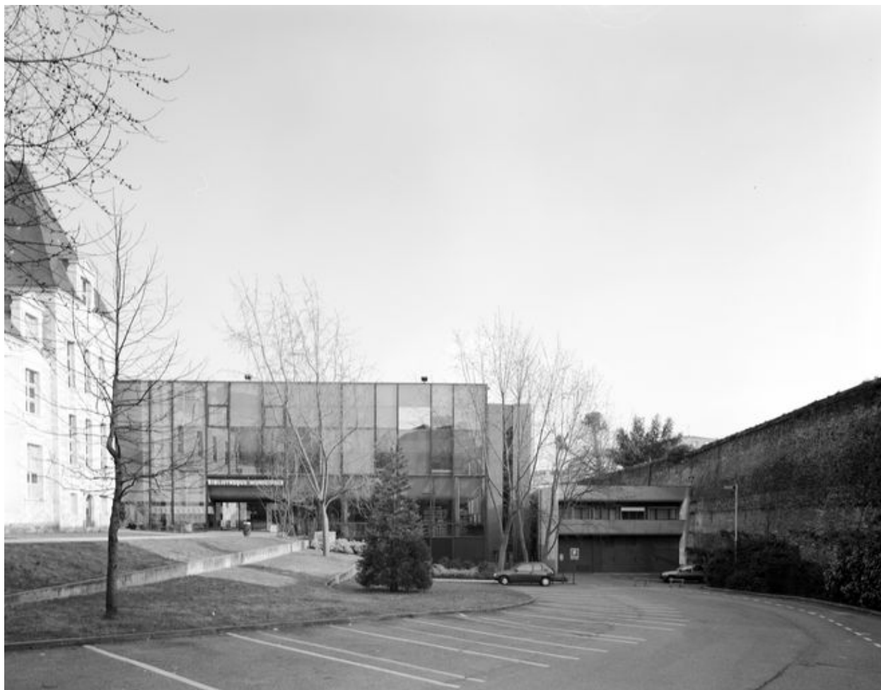
Bibliothèque municipale, vue d'ensemble de la façade principale.
