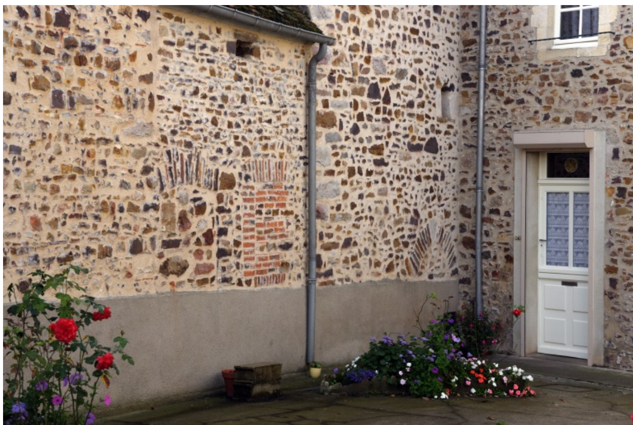
Vue de détail depuis la cour du 9, place Adam-Becker au nord : à droite, porte bouchée.
