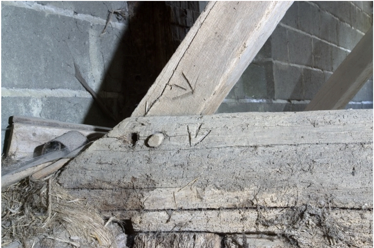
Détail de la charpente de l'étable-grange : marques d'assemblage.
