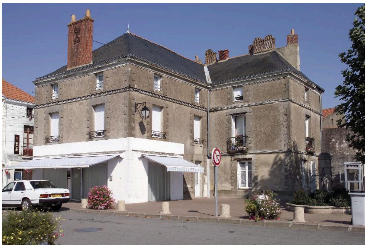
La maison n° 23 rue du Faisan, vue des façades postérieures.
