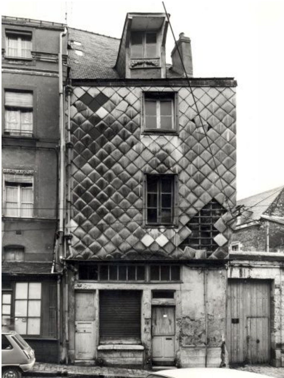
Elévation antérieure avant restauration.
