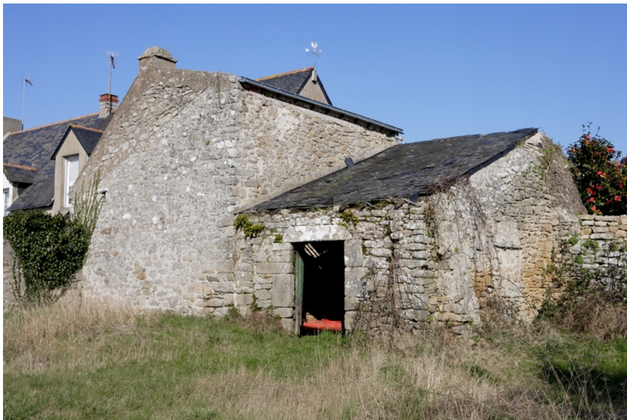
Vue du logis et de l'appentis depuis le sud-est.
