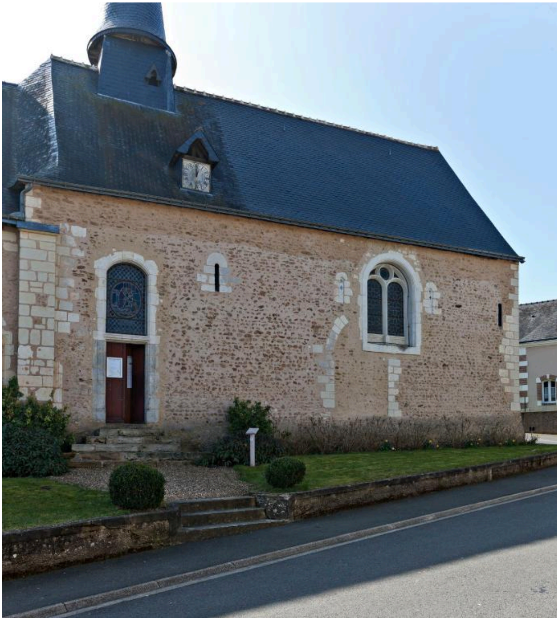
Nef, façade nord.
