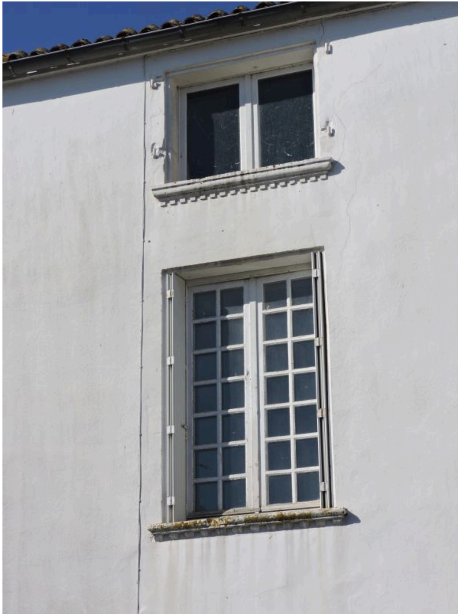
Détail d'une des travées : baies avec appuis moulurés et à denticules.
