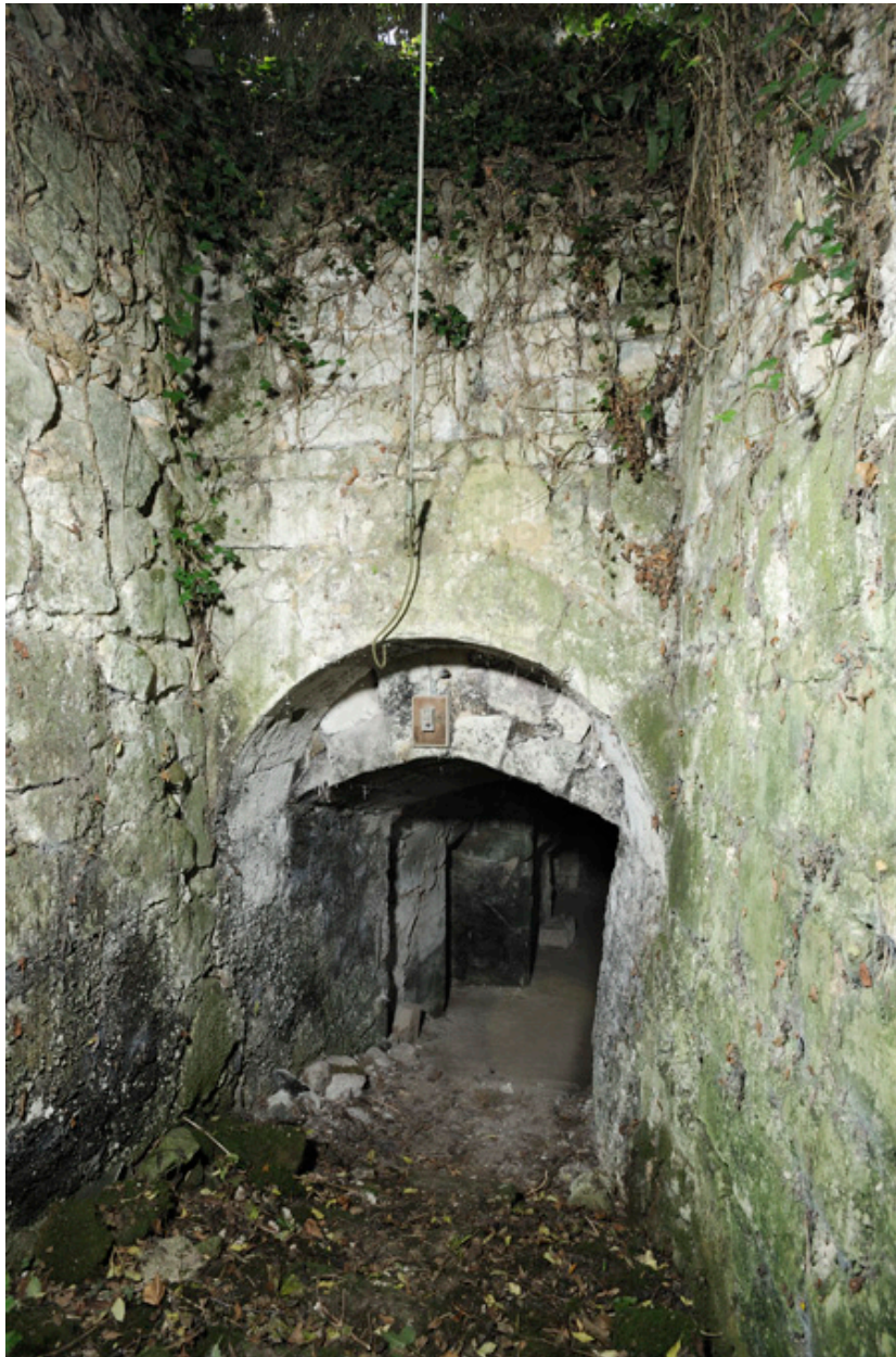
Vue générale : entrée de l'abri.
