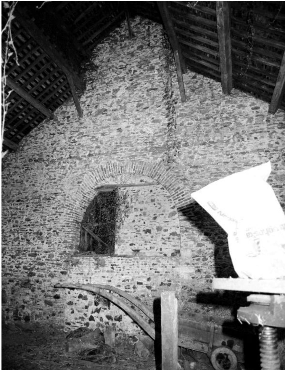
Intérieur de la halle de coulée (1984).
